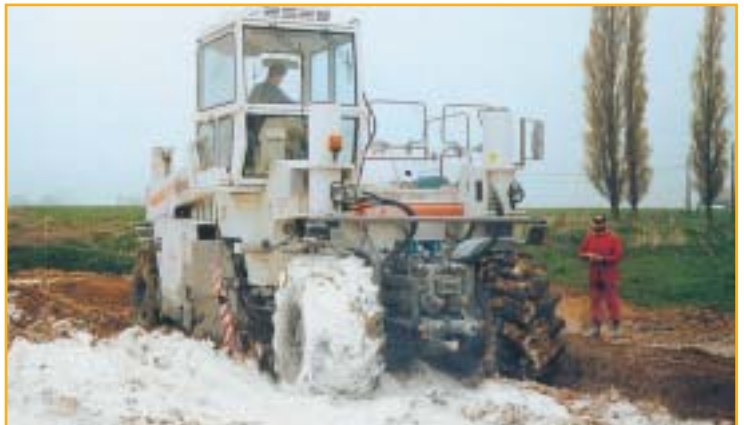
Objectif : réduire la circulation dans les agglomérations. Amélioration du sol à la chaux pour stabiliser la sous-couche d'une nouvelle rocade.
