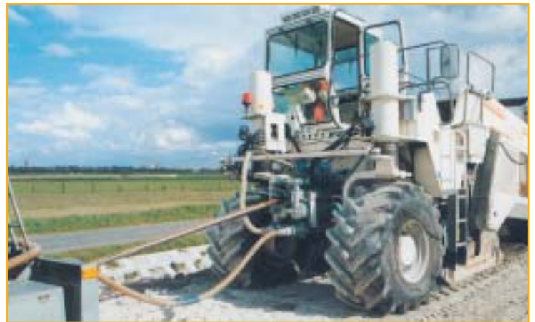
Incorporation de ciment avec apport simultané d'eau par le WR 2500 dans un mélange d'enrobés, de sable et de granulats.
