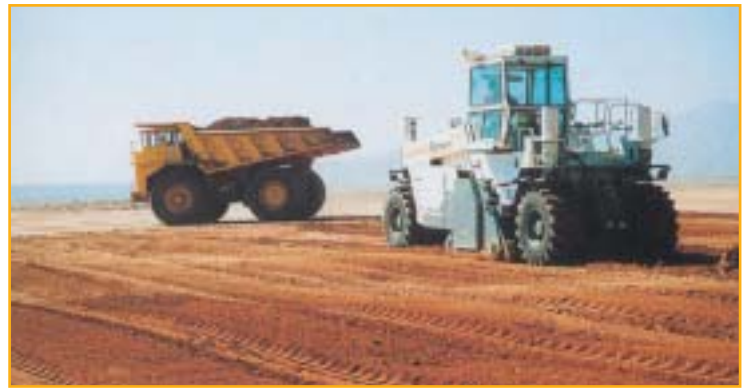
Homogénéisation de matériaux mixtes lors des travaux de terrassement pour la construction de la piste de décollage et d'atterrissage d'un aéroport international.
