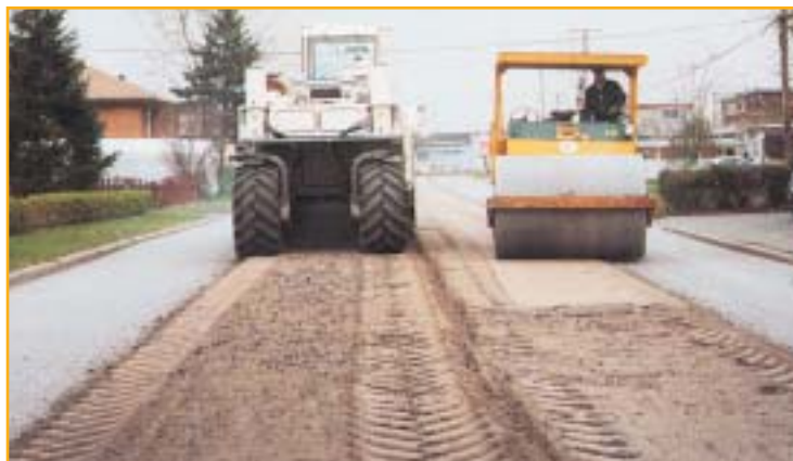
Les enrobés décohesionnés sont mis en oeuvre uniformément par le WR 2500, et peuvent être compactés directement
